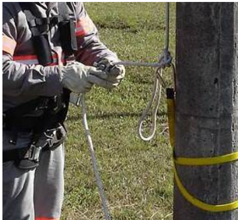
Figura 39 – Instalação do trava-quedas
