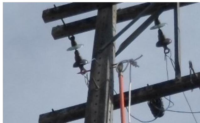
Figura 31 – Instalação do agulhão no poste
