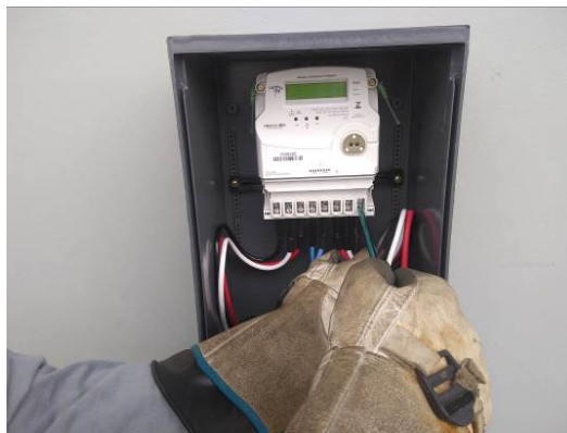
Figura 3 – Retirada do condutor de saída
